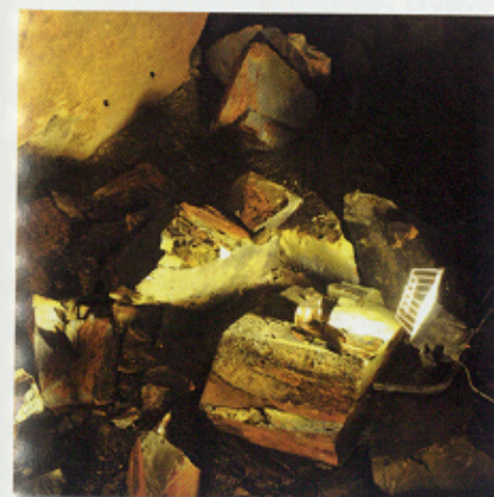
Quelques blocs sont détachés : du travail pour la semaine.
